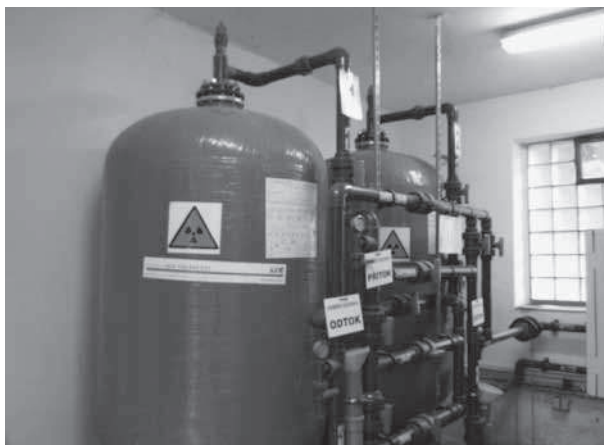
Рис. 1. Установка для очистки воды в системе водоснабжения
